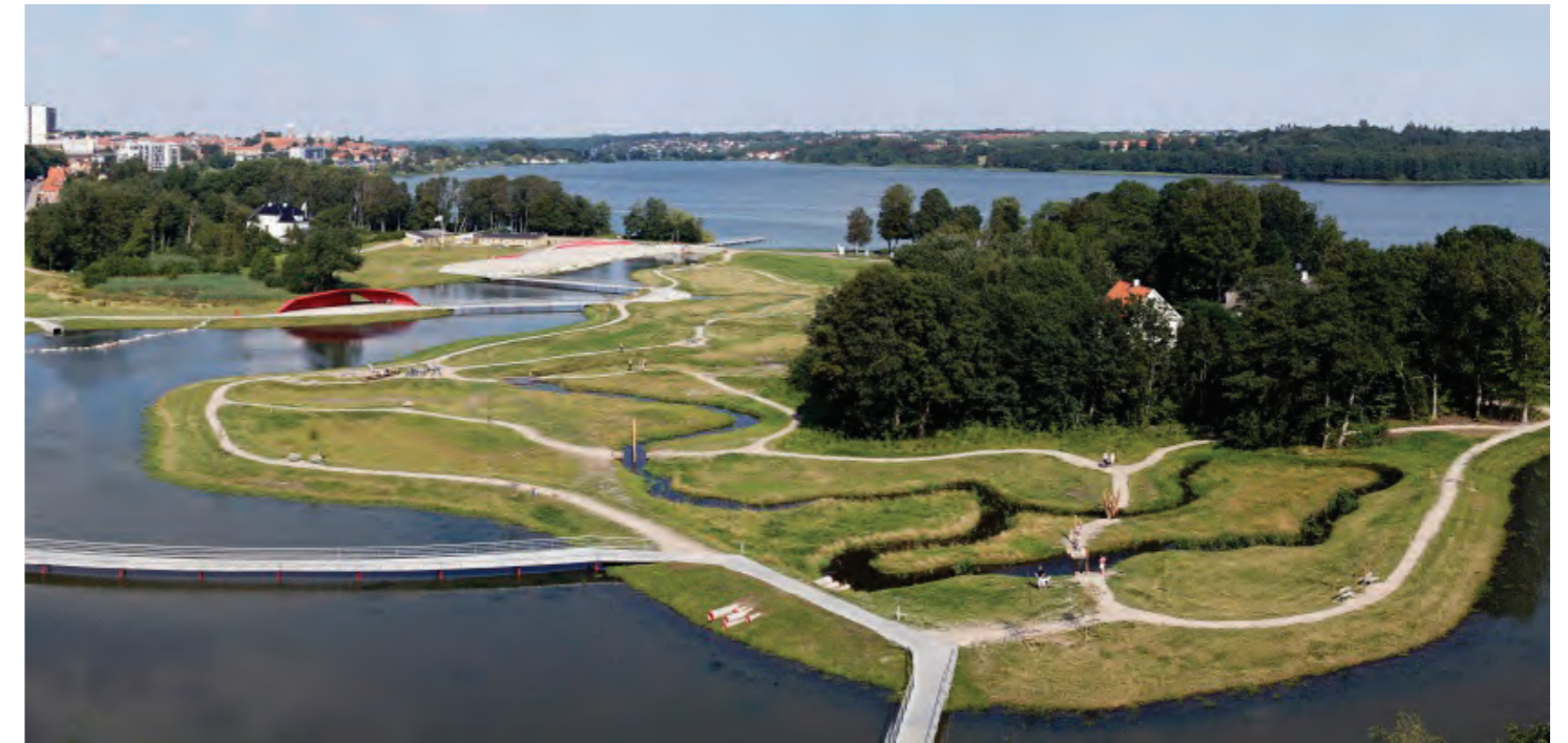
Et eksempel på kobling af regnvandshåndtering og aktivt uderum — Sønæs, Viborg - Møller & Grønborg Arkitekter Foto: Carsten Ingemann
