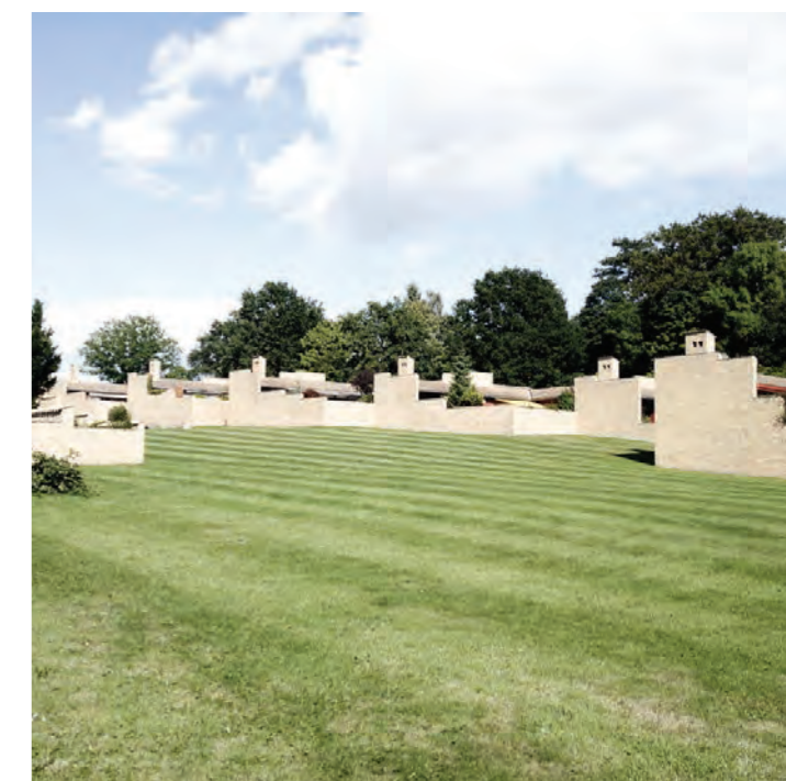
Reference: Fredensborghusene, Hillerød, Jørn Utzon Her skaber bebyggelsen rum for fællesskaber i tre skalaer. Foto: Ole Storjohann
